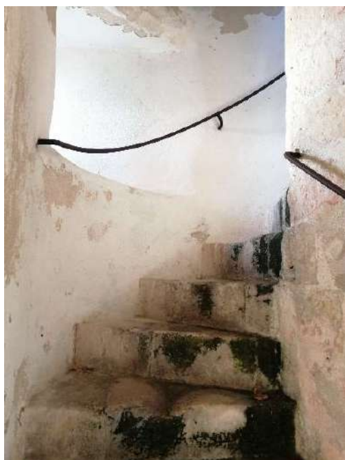
Légende : Escalier menant au chemin de ronde
